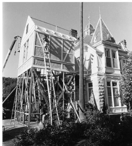
Links: Der falsche Anbau aus Westen fotografiert.
